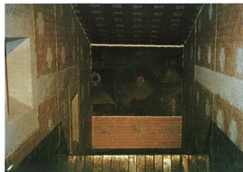
⑦焼却炉内部
