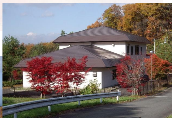
浸出水処理施設
