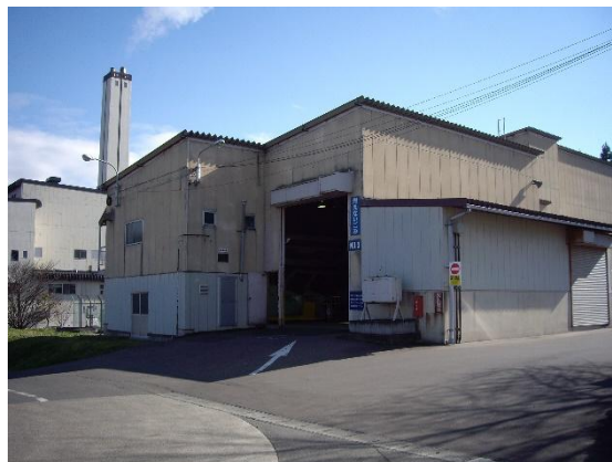
不燃ごみ処理施設
