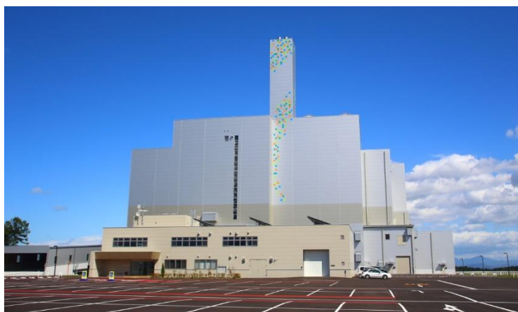
焼却施設（H27.10から）
