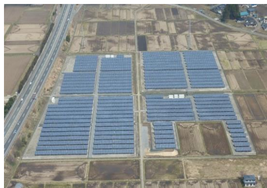
江釣子地内の新市庁舎建設予定地に設置された北上第1・第2ソーラー発電所
