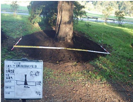
土壌改良材埋戻し完了
