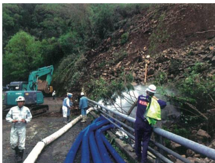
写真－2.3.3 県道西大山大野日田線斜面崩壊現場の上野川のポンプ排水 4)
