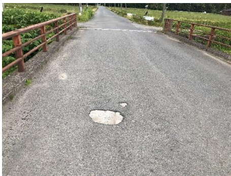
写真-3.4 路面の凹凸
