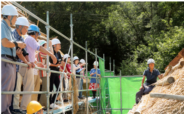
かやぶき屋根のふき替え工事見学会
