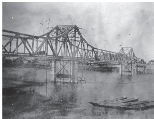
近代的な構造へと建設が進む珊瑚橋
