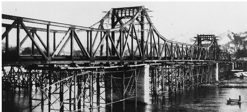
昭和8年木橋に変わり新珊瑚橋完成間近。上流に木橋が見える
