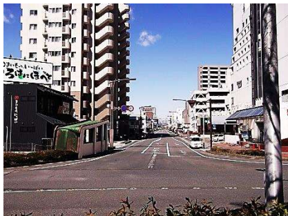
電線路の無いすっきりとした大通りの風景
