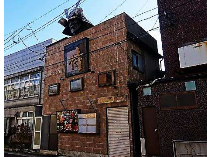
建物：飲食店の賑わいを演出した造りとなっています
