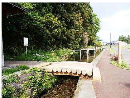
せせらぎと小みち：自然景観に溶け込む素材や色彩を使用しています
