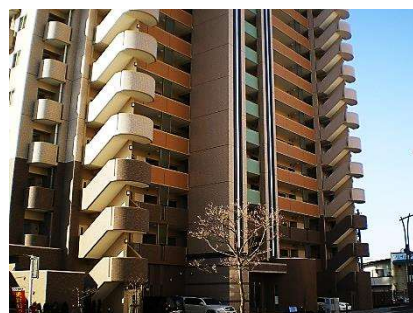
外階段：建物と一体となった造りになっています
