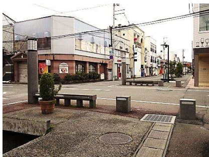
万世橋：通りのポイントとして、植栽や街灯等に工夫が施されています
