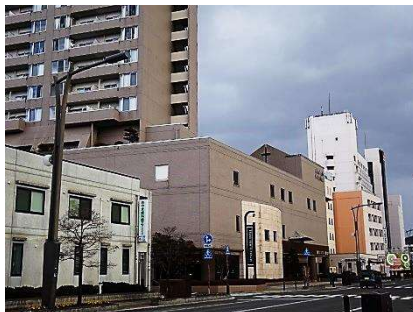
屋上：通りから室外設備等が見えないように配慮されています
