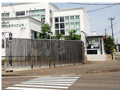
柵：周辺や植栽に溶け込む素材を使用し、目隠しの役割も担っています
