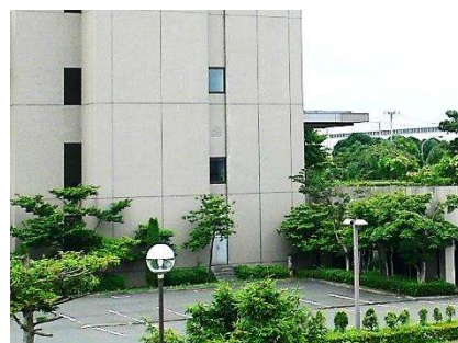
駐車場：植栽を配置し、緑化や通りからの視線に配慮しています
