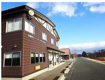
建物：周辺に馴染んだ色彩と素材を使用しています
