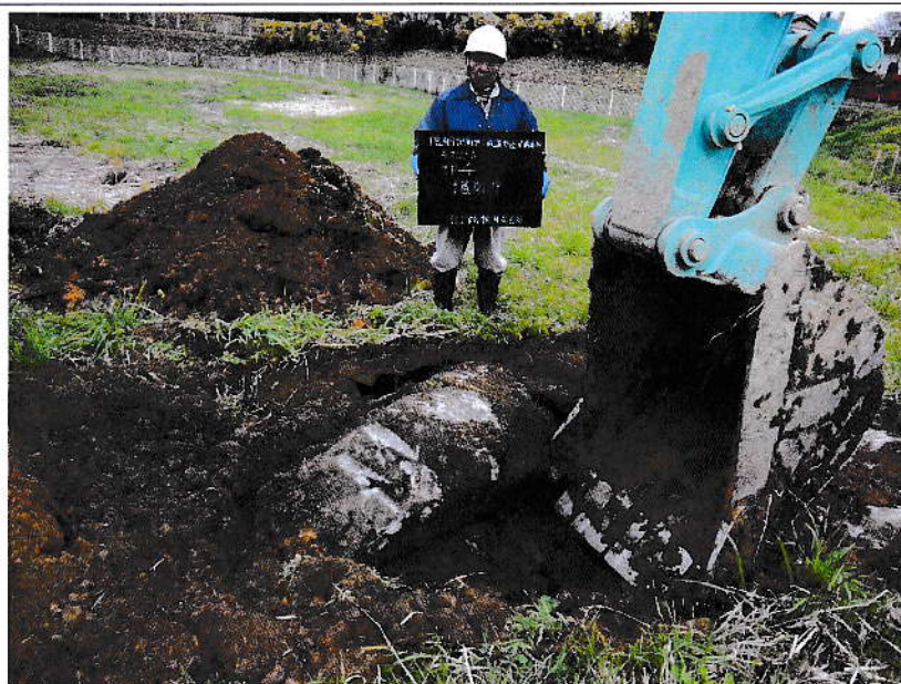
TP-4 掘削中 表層部に大礫混在。
