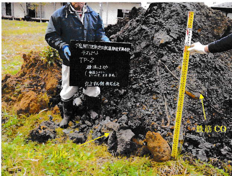
TP-2 礫混り土砂主体。 鉄筋コンクリート片、ビニール片、木片等少量散在。 大礫の混在少ない。
