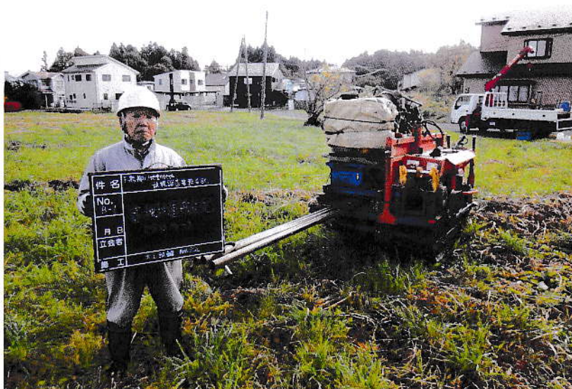
資材運搬状況
