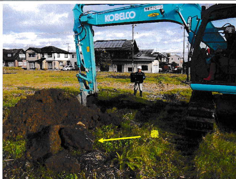
TP-5 掘削中 表層部に大礫混在。
