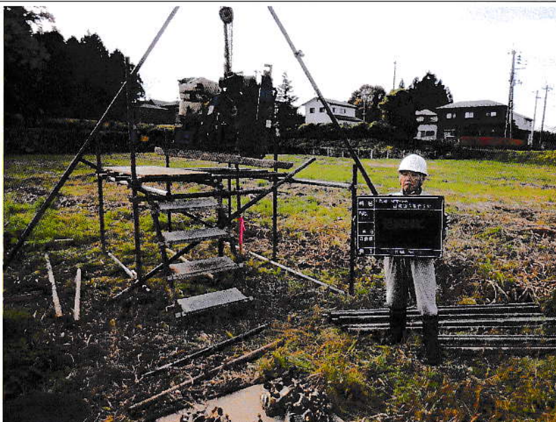
足場仮設状況
