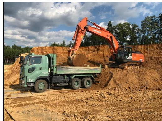
写真5 土砂積込運搬状況
