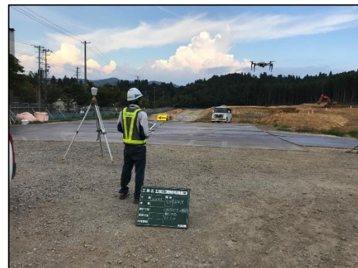
写真7 ドローンによる土量管理測量状況
