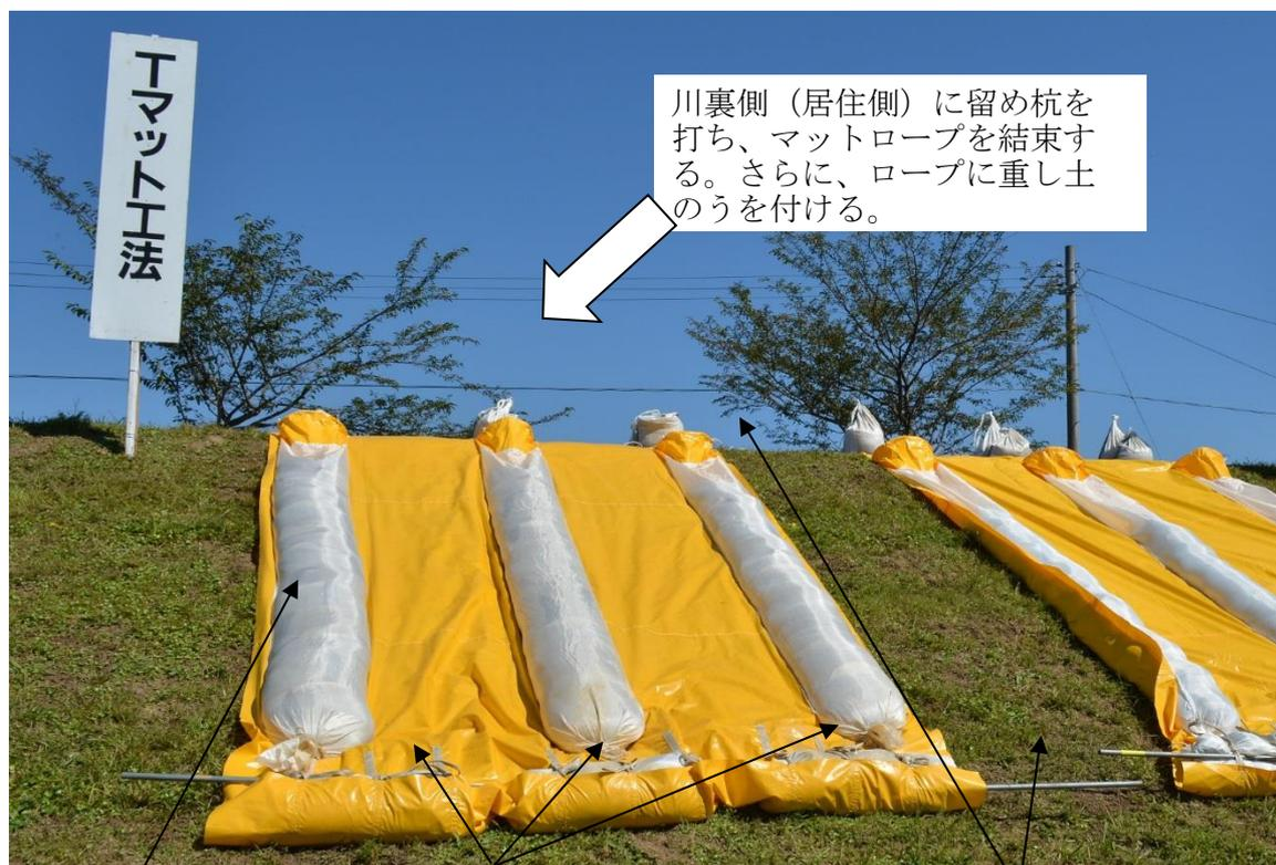
○土のう15袋    ○土のう3袋    ○上端、下端に鋼管を取り付ける。
