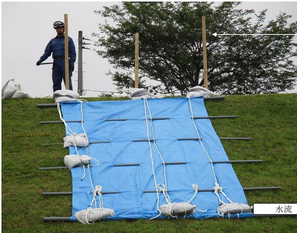
訓練のため手前に打ってあるが、実際は堤防反対側に打ってロープで固定する。
