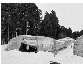
△大雪により倒壊したハウス(和賀町藤根)
