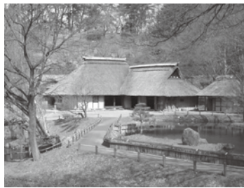
▲みちのく民俗村の旧星川家住宅
