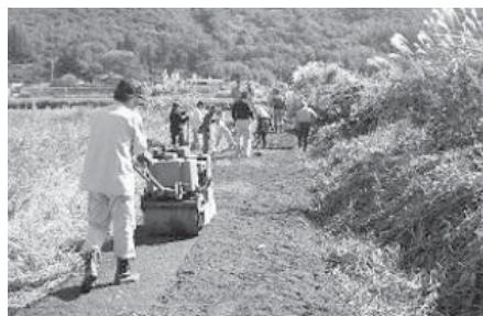
▲多面的機能支払交付金事業を活用した農道の舗装 (イメージ写真)
