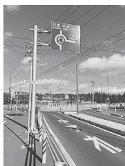
北上工業団地内の環状交差点
