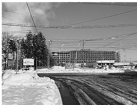
市道路線として認定した北上工業団地内の道路
