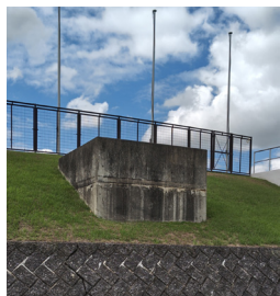
建設当時の夜間照明用の土台
