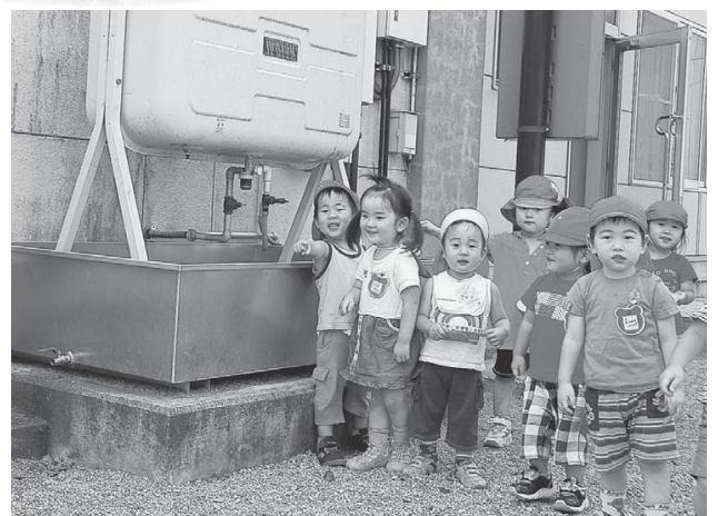
防油堤は、こぼれた油が外に流れ出すのを防ぎます(写真・大通り保育園)
