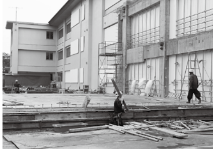
南中学校校舎改築工事 6億6,013万円
