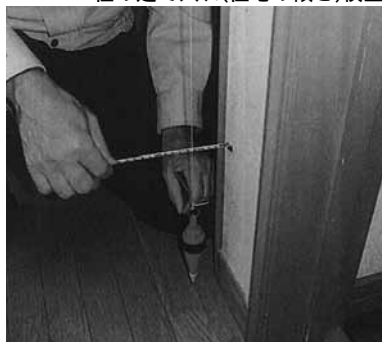
柱の建て入れ(住宅の傾き)検査
