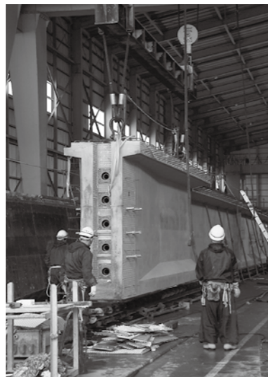
1本の橋りょうを切り分ける作業
