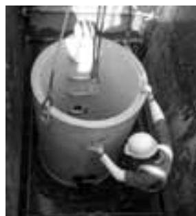
下水道マンホール設置工事
