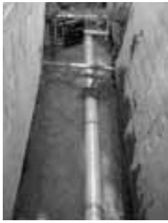
下水道管路布設工事
