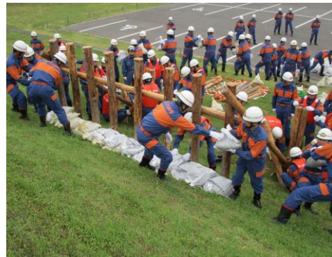
杭打ち積み土のう工法
