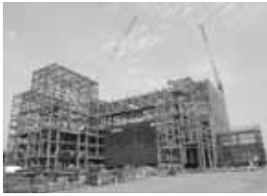
平成27年10月からの本格稼働に向けて建設中の同センター
