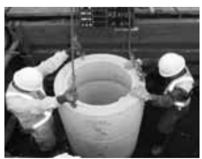
マンホールの設置工事
