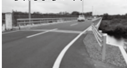
橋梁 りょう 長寿命化修繕事業 5億3,356万円
