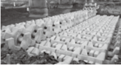
橋梁 りょう 長寿命化修繕事業
