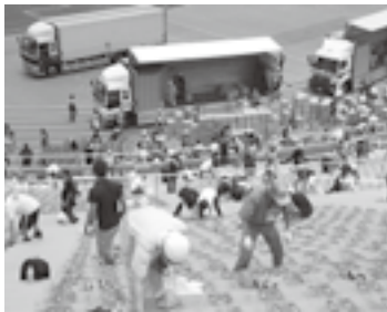
国立競技場での座席の取り外しと運搬車両への積み込み
