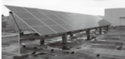
本庁舎太陽光パネル・蓄電池新設事業 6,050万円
