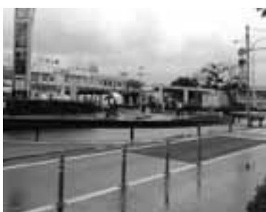
横断歩道が設置され、バリアフリー化が行われたJR北上駅西口
