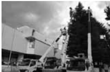
【北上地区電気工事業協同組合】リボンシャワー事業
