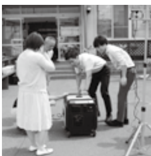
発電機の動作確認を行う市の職員
