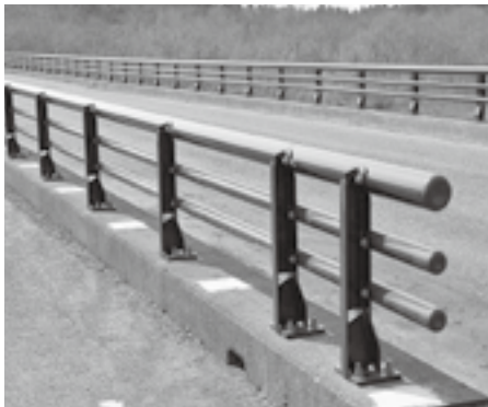
広表橋に設置されている防護柵
