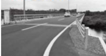
橋梁長寿命化修繕事業 5億3,356万円
