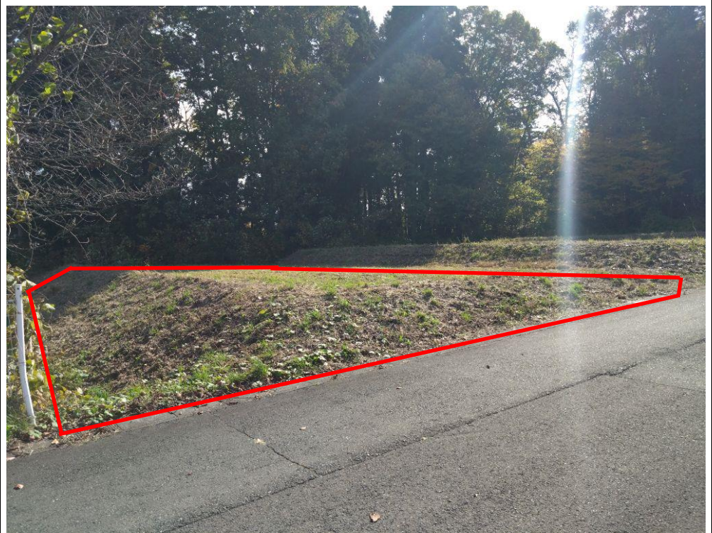
現況写真 (北西から撮影)
